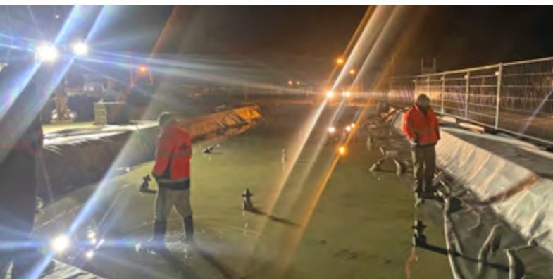
Nächtlicher Einsatz zur Sicherung der noch nicht fertiggestellten Baumaßnahme.
