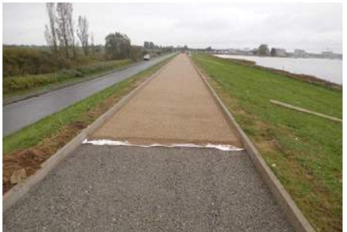
Der Unterbau mit Dränbeton in Vlies
