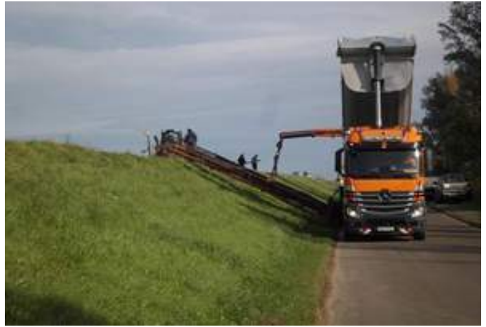
Belieferung des Betons von der Teerstraße
