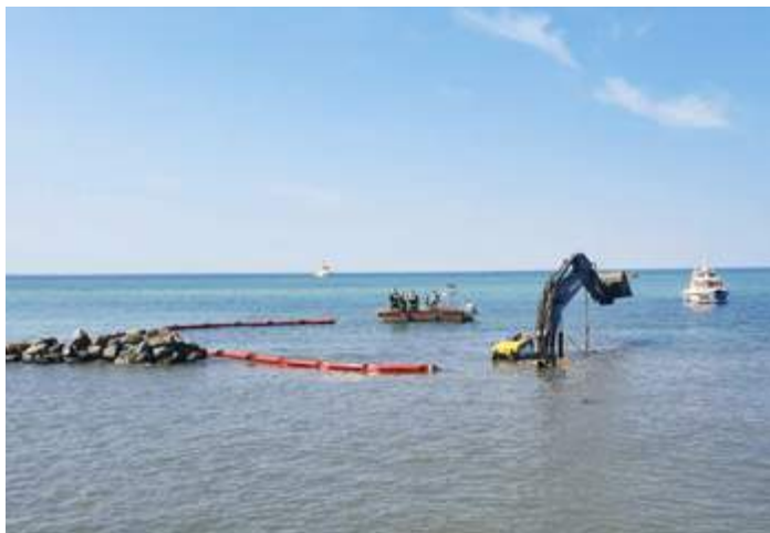
Ölsperren am Einsatzort Wendtorfer Schleuse
