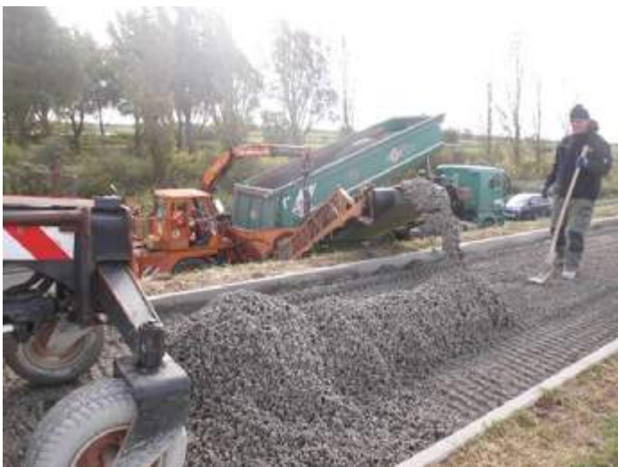
Einbau mit einem Förderband
