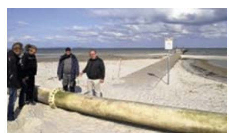
Der Steiner Bürgermeister Peter Dieterich (rechts) berät vor Ort mit den Mitarbeitern Uwe Oede sowie Walter Brömstrup von der Firma Deutsch-Dänische Wasserbau GmbH die Lage der Spülleitung für den Sand.
